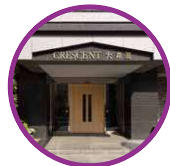
自動扉化した出入口
